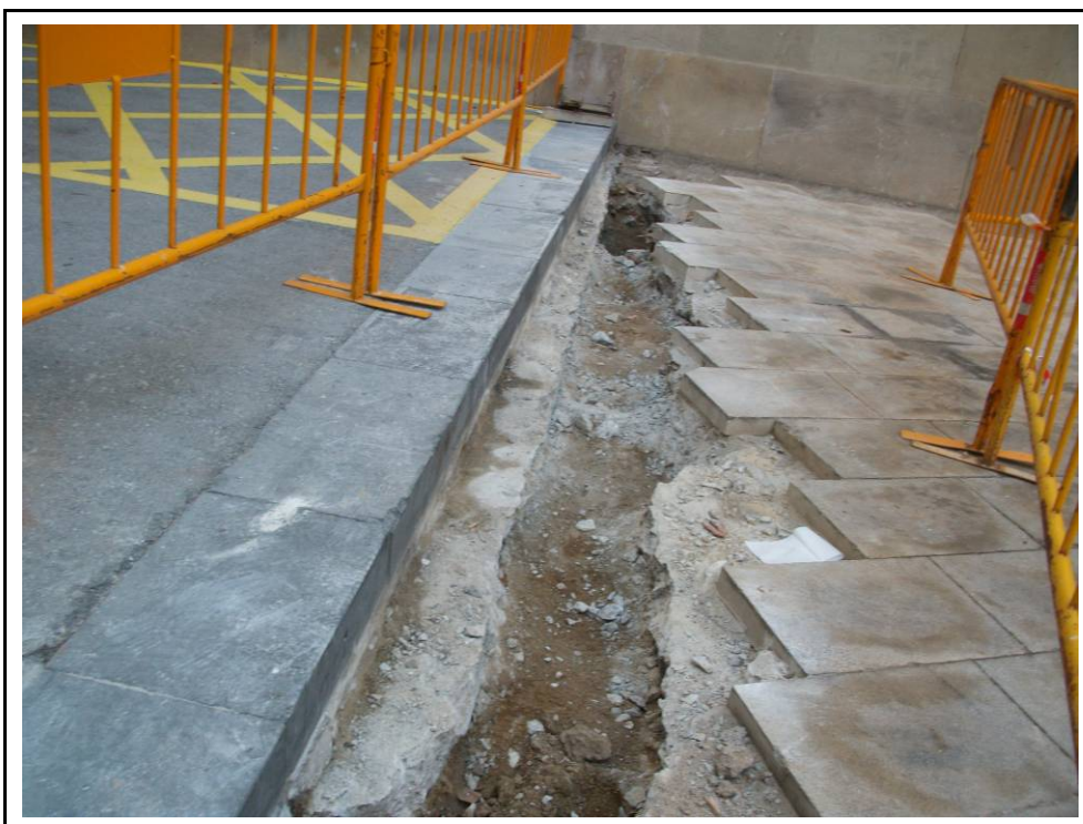
Foto 4: Rasa sense paviment actual.
