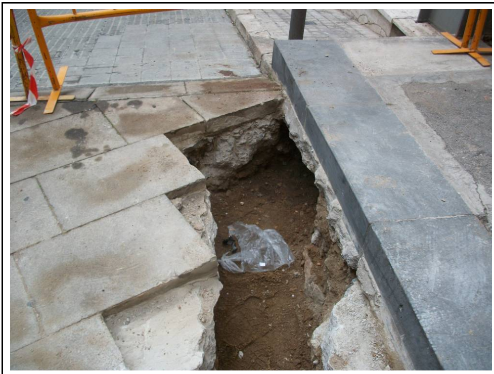
Foto 9: Rasa a la zona de connexió.
