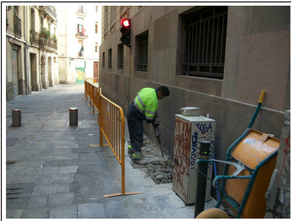
Foto 1: Operari amb martell pneumàtic.
